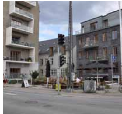
Eksisterende gavl med nye altaner og afslappet udeservering på hjørnet i forbindelse med café (Kbh V).
