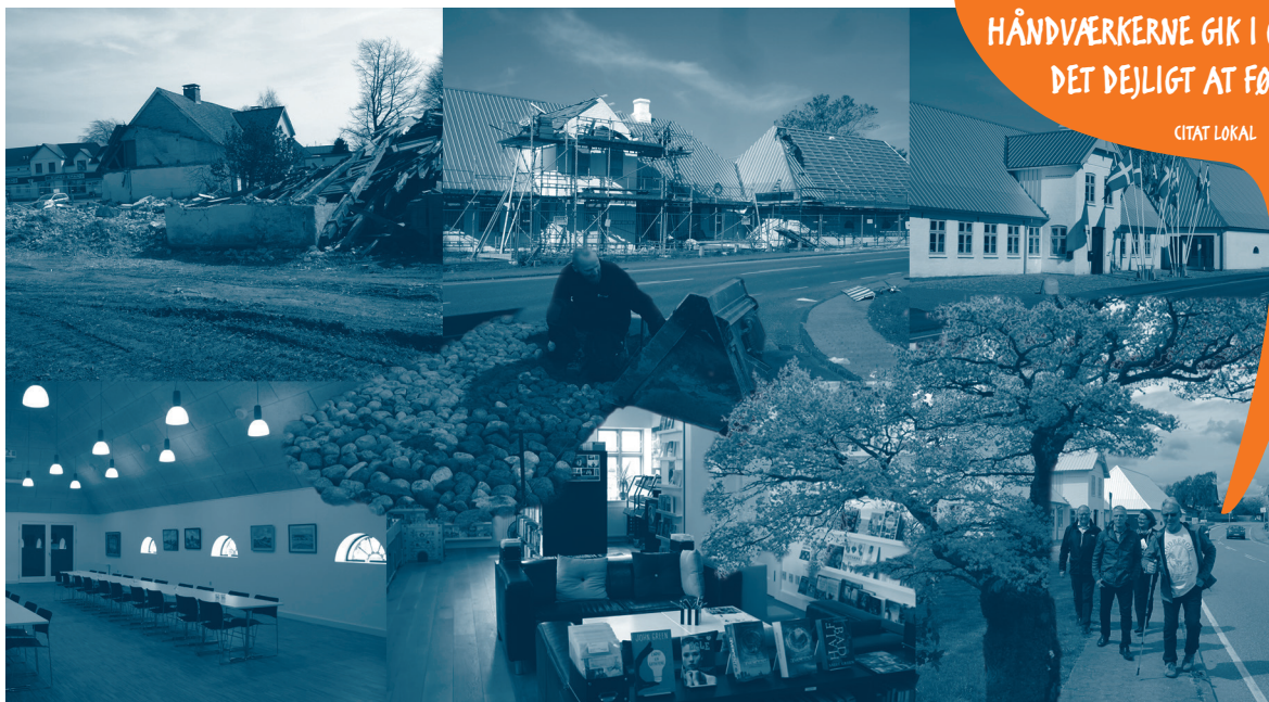
"Damms Gård" bygges om til medborgerhus. Foto: AAbyfornyelse og Aabenraa Kommune.
