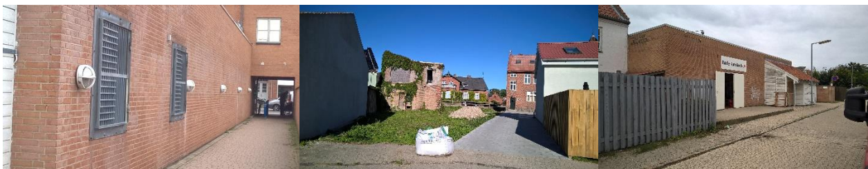
Billederne viser et eksempel på en eksisterende passage, brandtomten samt et udsnit af bagsiden af Jernbanegade ud mod Meny. Foto: Milena Rudez, Faxe kommune
