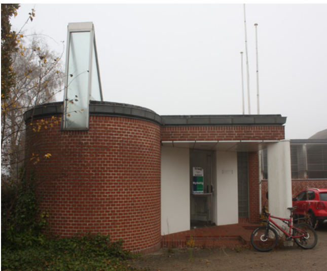
Indgangsparti til administrationsbygning
